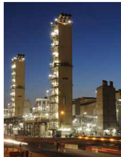
PEARL GTL, KATAR Endproduktfraktionen zerlegt wird.
